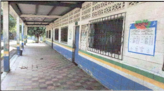
Foto 3: sustitucion de piso ceramico, cambio de lamina por lamina traquelada calibre 26
